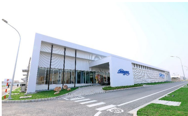
竣工したベトナム工場の外観
